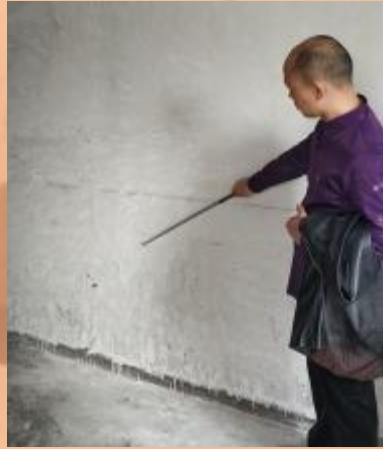
拆瓷砖铲墙表面拆除平整无凸出部分检查墙体水泥砂浆批荡层有无空鼓
