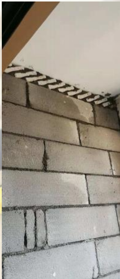
新砌墙体顶部用小砖斜砌蜈蚣脚
