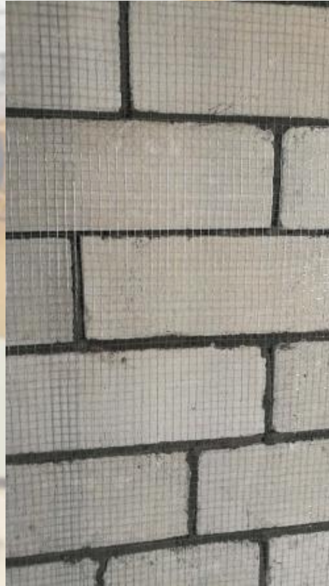
新砌墙体先挂一层钢丝网再批水泥砂浆防开裂
