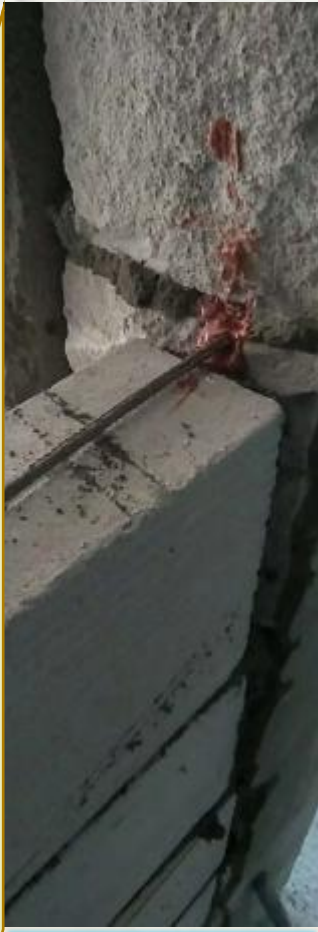
新老墙体衔接部分插五十公分长螺纹钢
