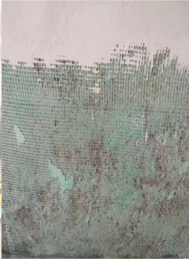
墙面挂纤维网
