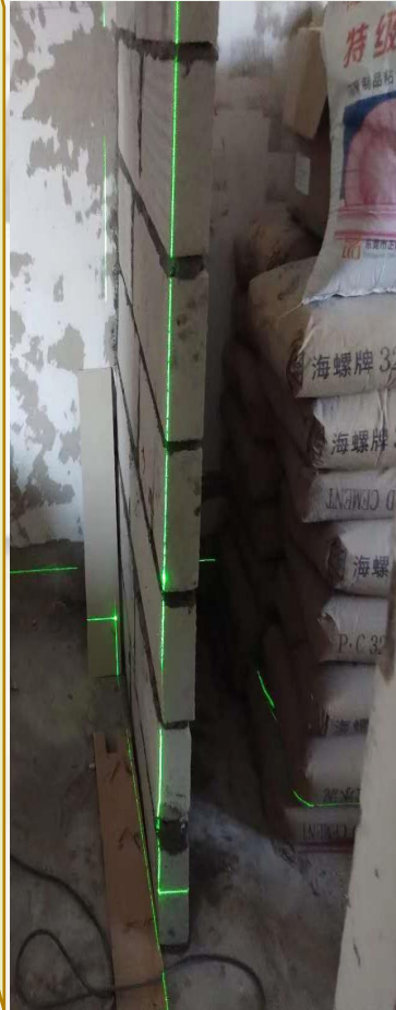
新砌墙体垂直放线
