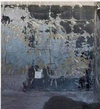
拆瓷砖铲墙表面拆除平整无凸出部分检查墙体水泥砂浆批荡层有无空鼓
