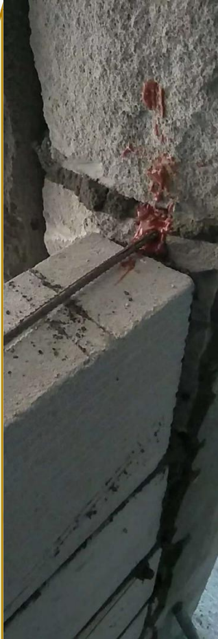
新老墙体衔接部分插五十公分长螺纹钢
