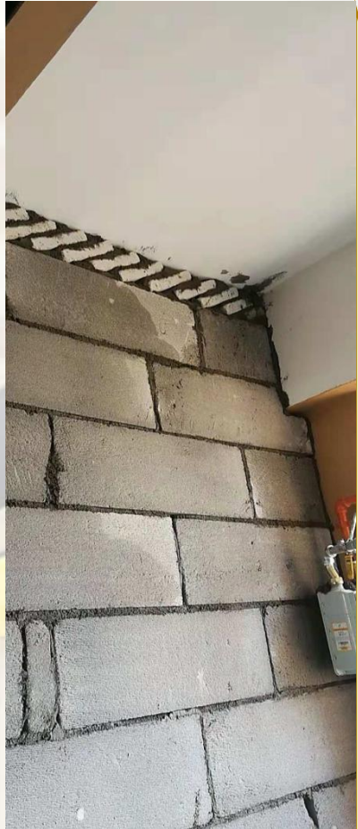
新砌墙体顶部用小砖斜砌蜈蚣脚
